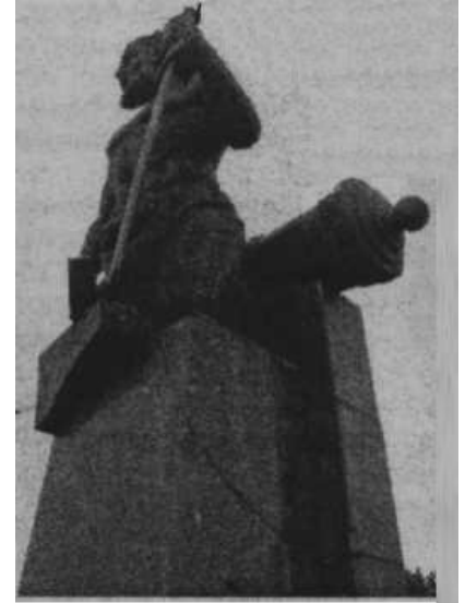
Постамент памятника Н. Демидову дал трещину
